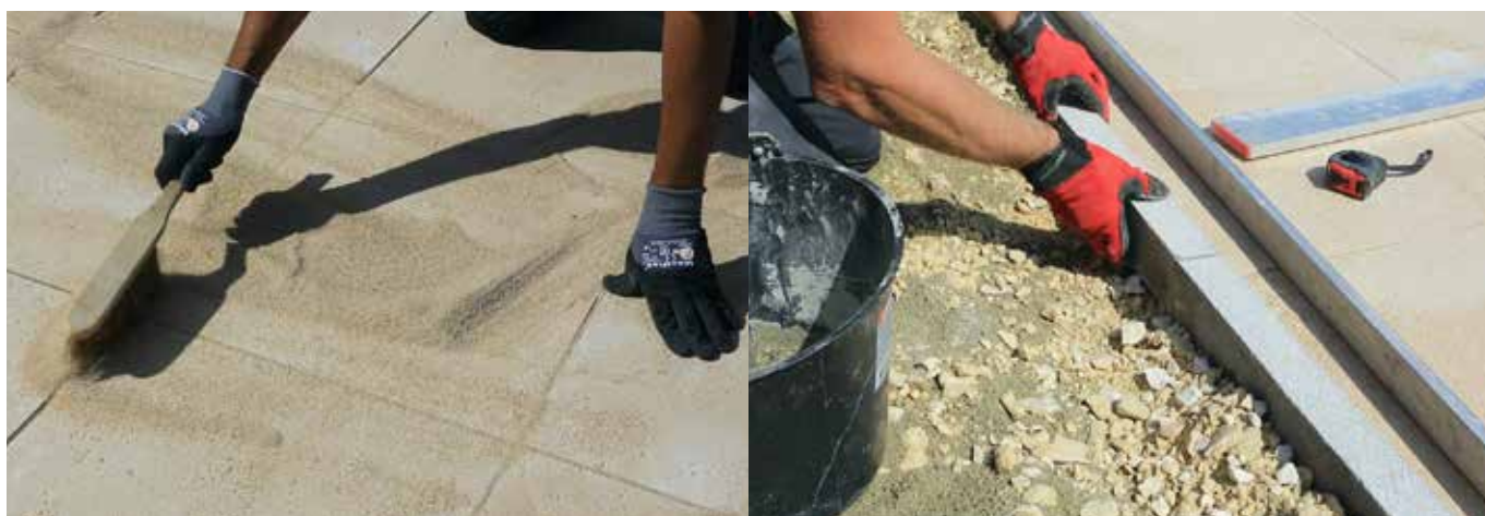
11 – Réaliser les joints avec du sable fin. Répartir le sable sur toute la surface avec un balai. Taper sur les dalles avec le maillet en caoutchouc afin de faire descendre le sable dans les joints. Compléter le remplissage des joints si nécessaire.
