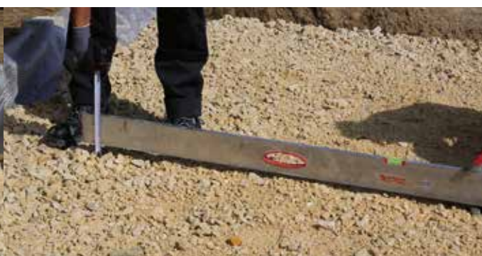
4 – Vérifier le niveau de la pente (2%).
