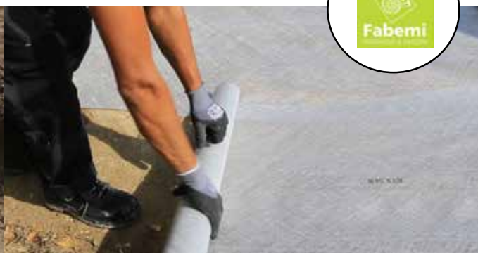
2- Dérouler le géotextile sur le fond de forme.
