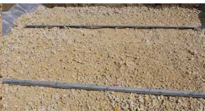
6 – Placer les réglets en respectant une pente de 2%. La partie supérieure des réglets doit dépasser de 3cm la couche du tout-venant.
