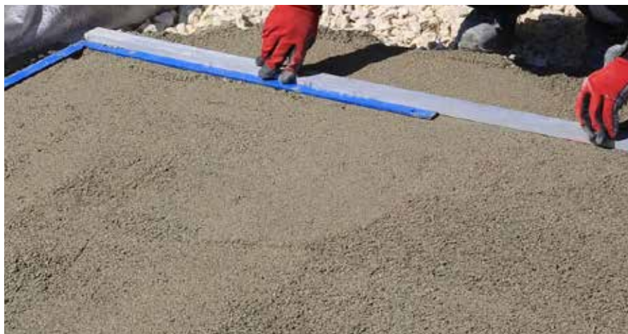
9 – Positionner une règle qui servira de base pour la pose du premier rang.
