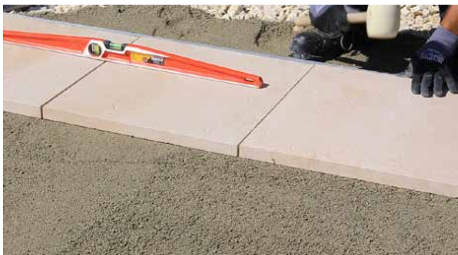
10 – Poser les dalles en réglant le niveau avec un maillet en caoutchouc. La largeur des joints entre les dalles doit être de 5 mm minimum.
