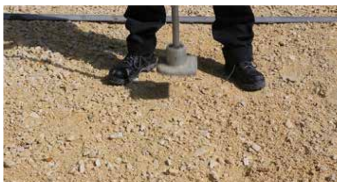
5 – Compacter le tout-venant.
