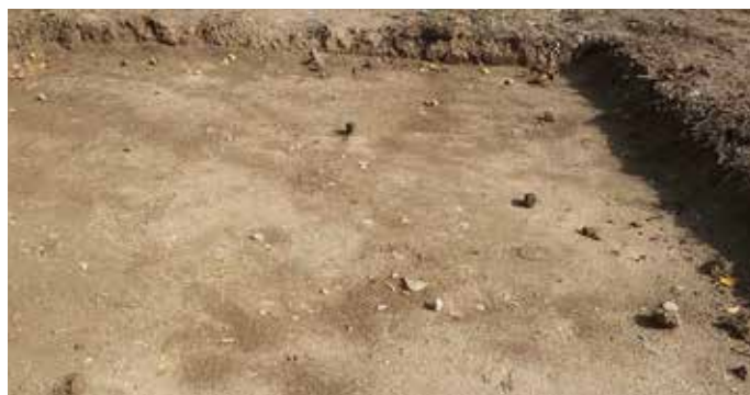
1 – Réaliser un terrassement sur une profondeur de 15cm. Le fond de forme doit respecter une pente de 2%, soit 2 cm par mètre.
